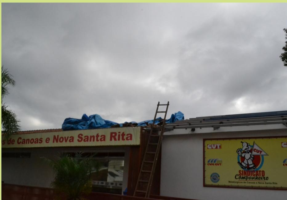
Desde o final de abril, a sede do sindicato vem ganhando um telhado novo. No lugar da estrutura de madeira e das pesadas telhas de barro, estão sendo colocadas estrutura e telhas metálicas muito mais leves e duradouras. A obra de substituição foi necessária porque o telhado de mais de 30 anos de idade estava apodrecido, com telhas quebradiças, infiltrações de umidade e com o madeiramento comprometido pela ação de cupins.
