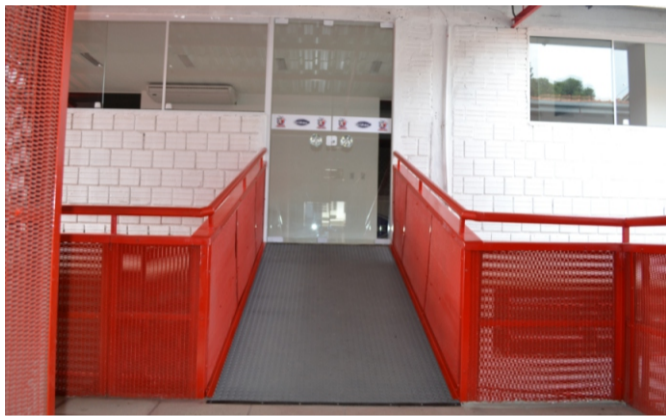
Acesso à nova área de lazer para portadores de necessidades especiais e idosos pode ser usado como saída de emergência
